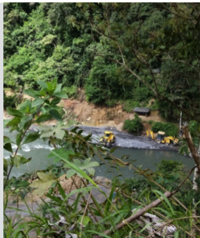
Figura 4. Maquinaria en la rivera del río Inambari
