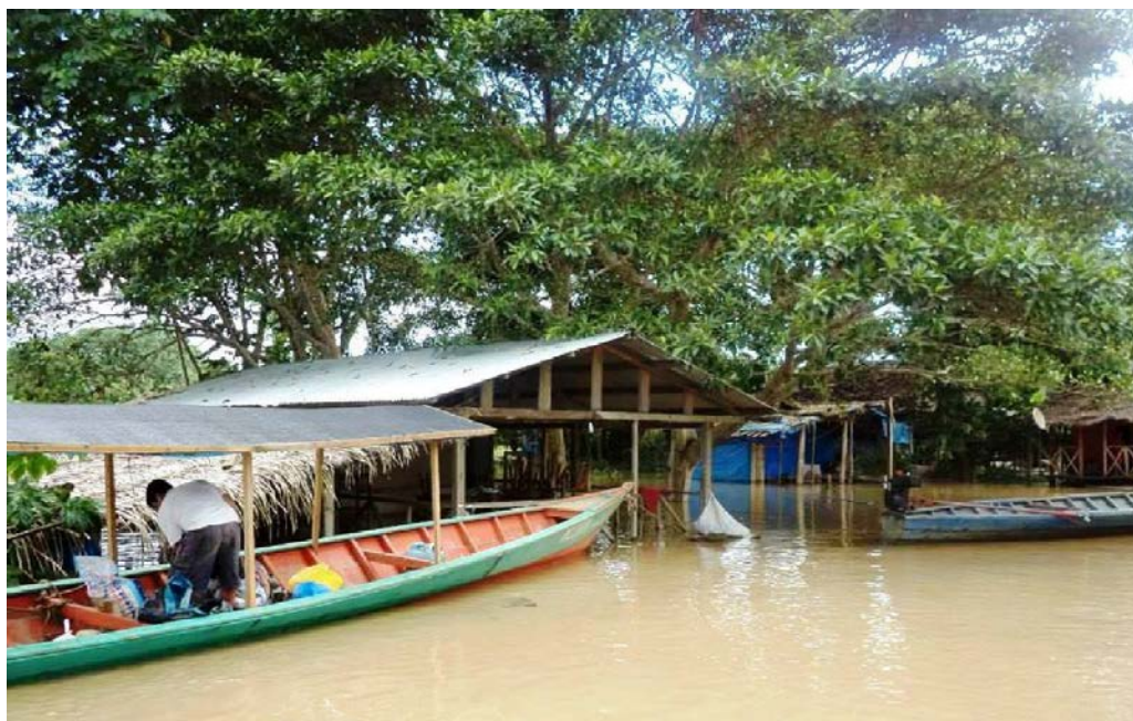
En la fotografía la población de Puerto Arturo completamente inundada (febrero de 2014). Foto tomada por el equipo de CEAS en Madre de Dios
